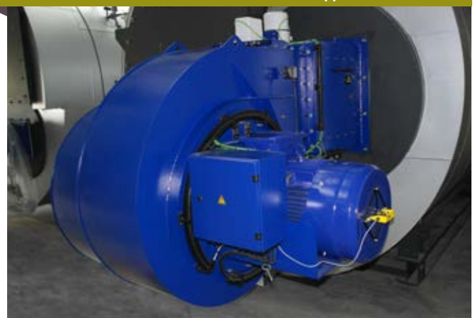
TEMINOX GL im Einsatz an einem Flamm- & Doppelflammrohrkessel
